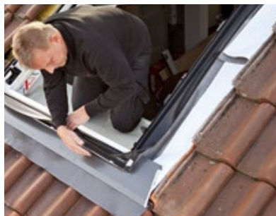
Der umlaufende Eindeckrahmen bindet das Fenster in die Dachdeckung ein
