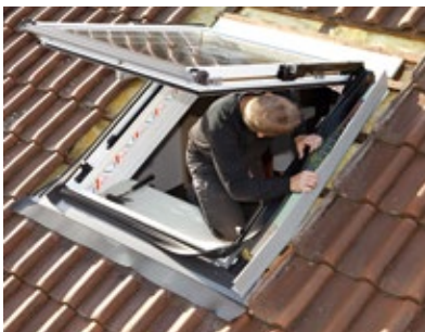
Das neue, passgenaue Maß-Renovierungsfenster wird eingesetzt
