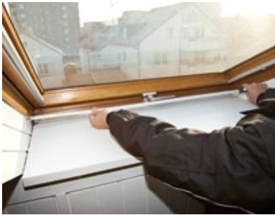
Einfach Maß am Innenfutter des alten Fensters nehmen und bestellen
