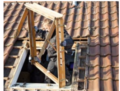
Der Dachhandwerker demontiert das alte Fenster und baut es nach innen aus
