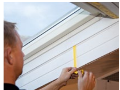
Übergänge zum bauseitigen Innenfutter werden mit den Verleistungsprofilen abgedeckt
