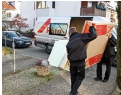
Nach 8 Arbeitstagen ist das passgenaue Designo Maß-Renovierungsfenster da
